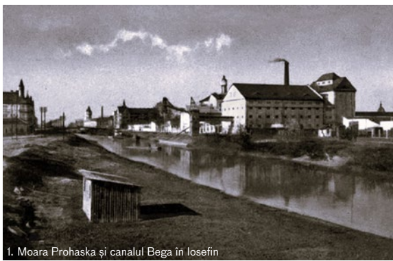
1. Moara Prohaska și canalul Bega în Iosefin
